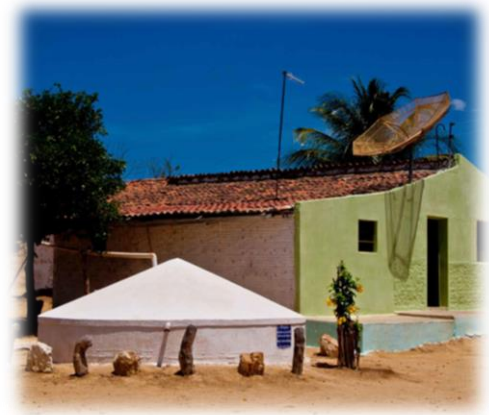
Figura 6 - Cisterna de placa de concreto construída no âmbito do P1MC. Fonte: ASA, 2017.
