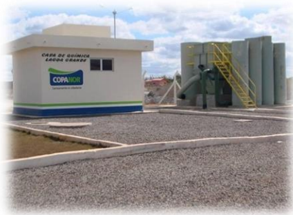
Figura 2 - Sistema de abastecimento de água da Copanor de Lagoa Grande, em Taiobeiras (MG).
