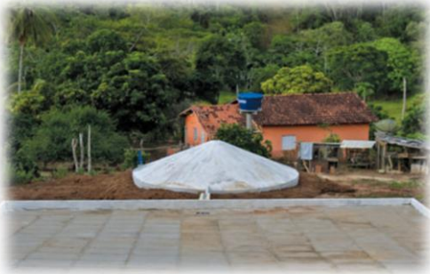
Figura 7 - Cisterna-calçadão do P1+2 para produção de alimentos. Fonte: ASA (2017).
