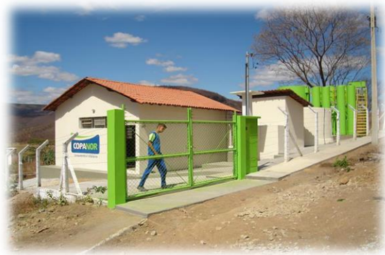
Figura 18 - Estação de tratamento de água. Fonte: Moreira Júnior (2012).
